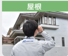
劣化、欠損、金物等の不具合等
