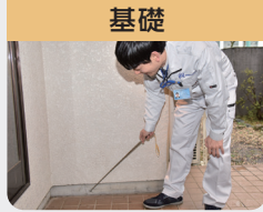
ひび割れ、欠陥や劣化等
