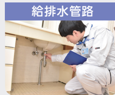
水漏れ、排水不良、滞留等
