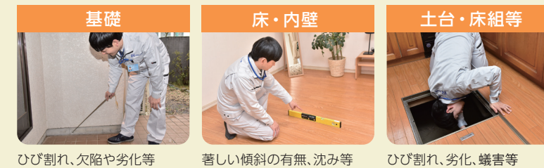
ひび割れ、欠陥や劣化等
