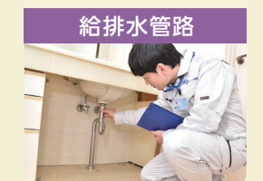
水漏れ、排水不良、滞留等
