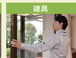
開閉不良、外壁との隙間
