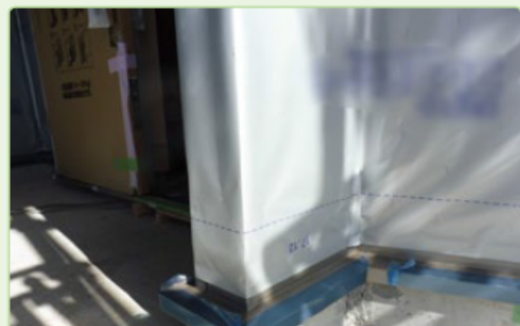
外壁水切りの施工状況
