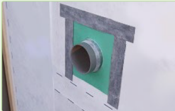
換気口等貫通部の防水措置
