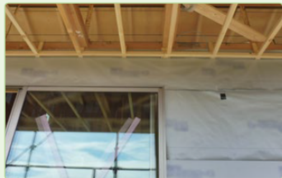
サッシ周囲の施工状況
