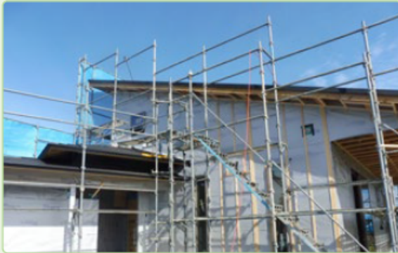
外壁防水下地完了
