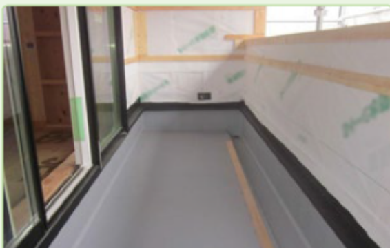
バルコニーの防水施工状況
