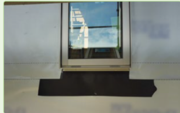
サッシ周囲の施工状況
